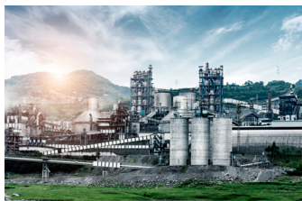
Stavební hmoty přeprava cementu potřebný tlak 4 bar
